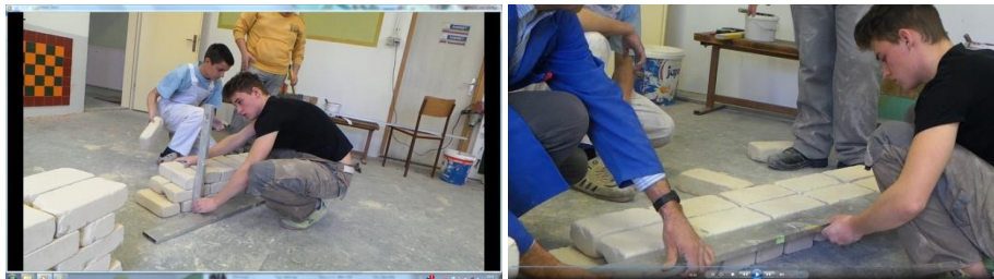
Analiza – razlikovati posamezne opečne zveze. Vir: gradbeni aktiv SESGŠ
