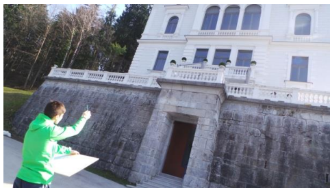
Kamniti oporni zid s portikom (centralni vhod v poslopje) in stopniščni hodnik, ki vodi na teraso. Vir: gradbeni aktiv SESGŠ
